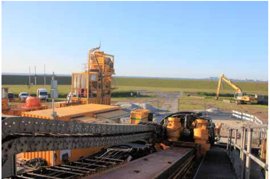
A.Hak Drillcon heeft vanaf Texel een aantal proefboringen verricht om de gesteldheid van de bodem onder het Marsdiep in kaart te brengen.
